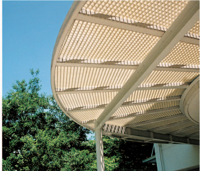
FRPグレーチング施工例
