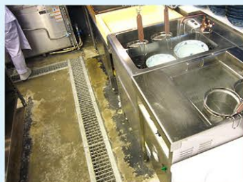
厨房（スチール）
