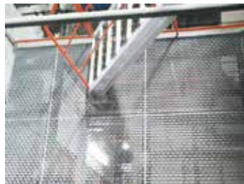
38.プラント施設
