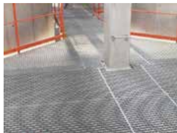
37.プラント施設
