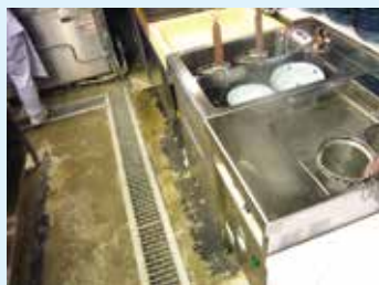
厨房（スチール）
