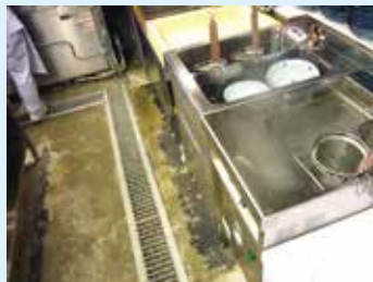
厨房（スチール）
