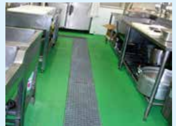
厨房（スチール）
