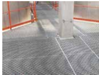
37.プラント施設
